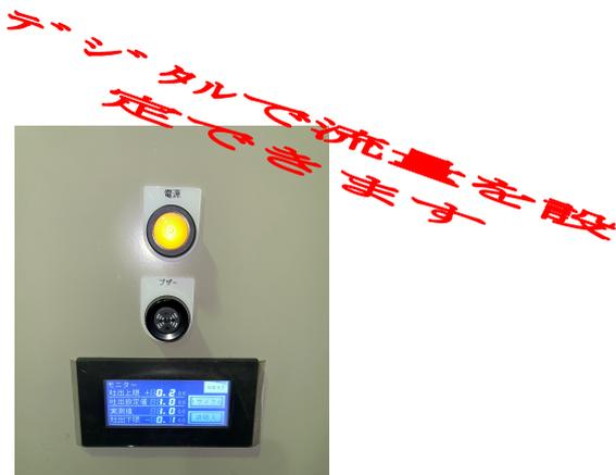
本装置は、ダイカストマシンからの信号で、プランジャスリーブの清掃を行いプランジャ潤滑油を当社オリジナルの定量吐出ポンプを使い、タッチパネルで設定した流量で停止します。
